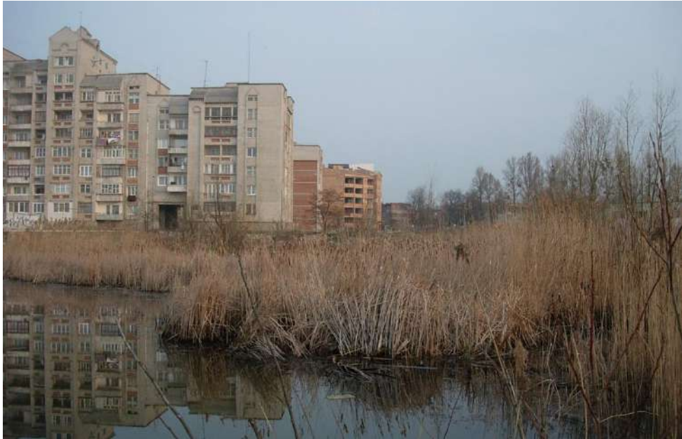
Рис.4.9 Підтоплена багатоповерхова житлова забудова на півночі міста
